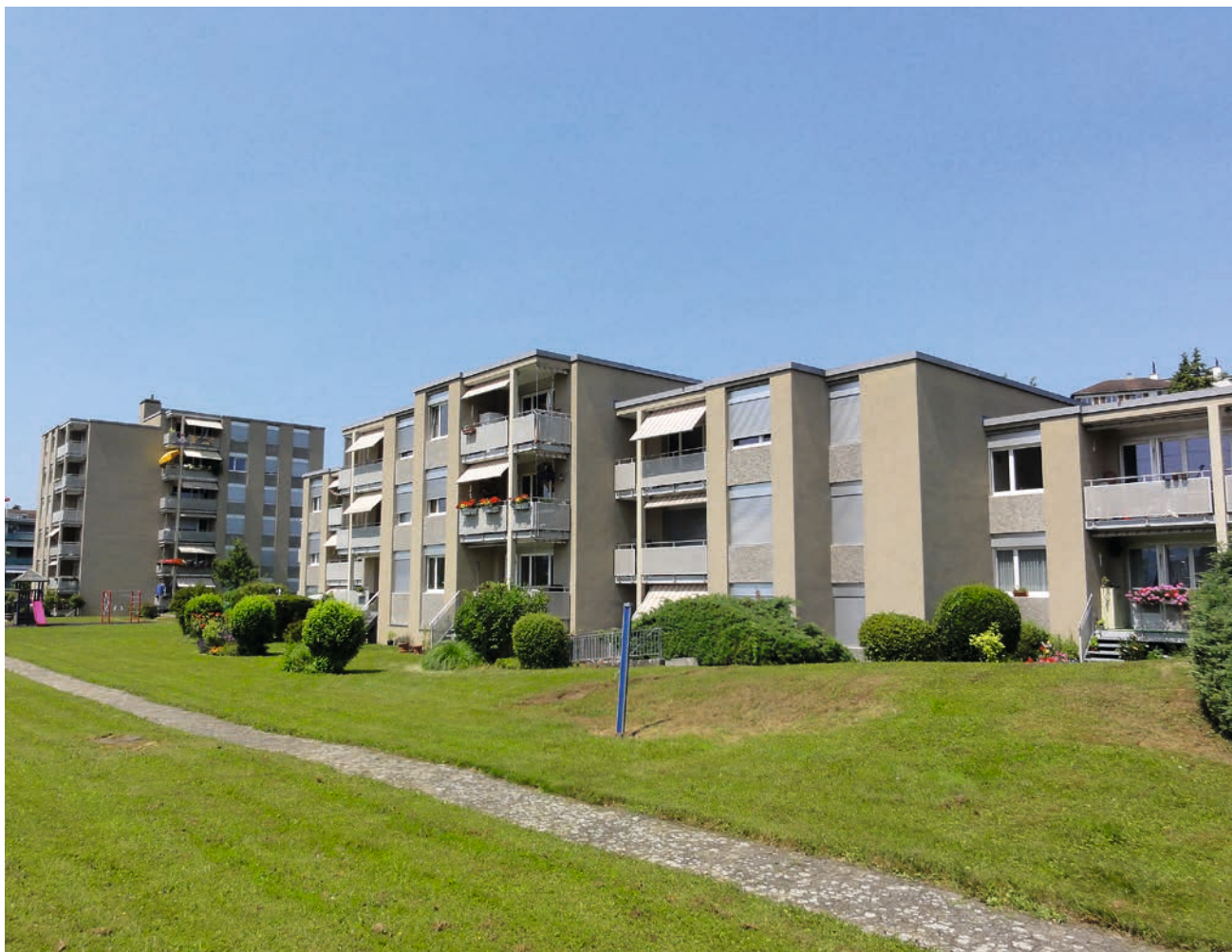
Immeuble Herweg 18-24, 28-32, Männedorf
