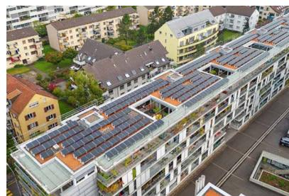
**Rénovation énergétique Dennlerstrasse 25-39 à Zurich:** rénovation des installations électriques, rénovation du toit plat et construction d'une installation photovoltaïque de 124 000 kW, mise en place e-mobility (Siemens), etc.
